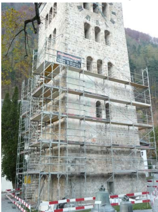
Die Renovation ist weit fortgeschritten: Die links noch zu erkennende Feuchtigkeit ist durch das Ausspitzen der Fugen und dem Trockenlegen des Turmfusses gewichen. Auf dem Foto links ist alte ausgespitzte (rechts) und neu aufgebaut und ausgefugte Kirchenmauer gut zu erkennen.
