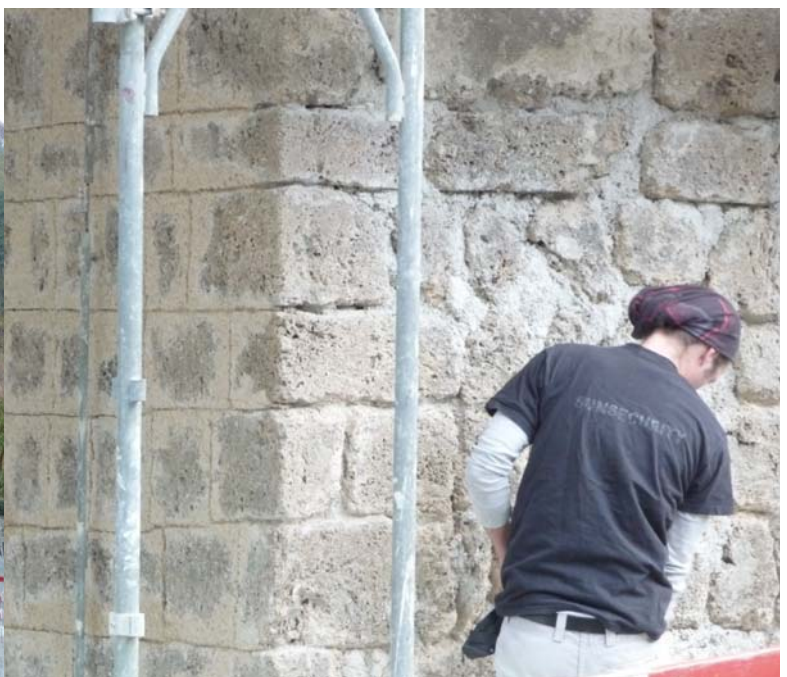
Die Renovation ist weit fortgeschritten: Die links noch zu erkennende Feuchtigkeit ist durch das Ausspitzen der Fugen und dem Trockenlegen des Turmfusses gewichen. Auf dem Foto links ist alte ausgespitzte (rechts) und neu aufgebaut und ausgefugte Kirchenmauer gut zu erkennen.
