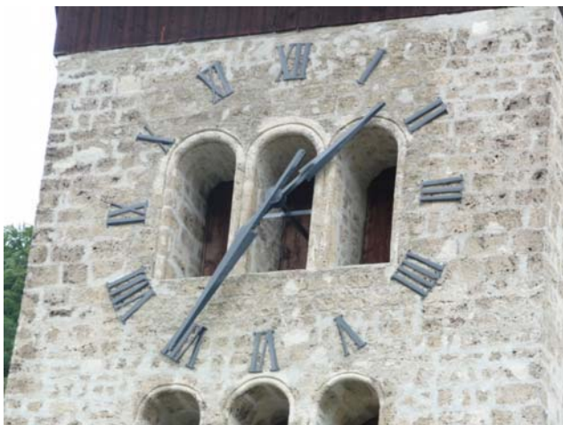
Die aufgearbeiteten Ziffern und Zeiger sind gut sichtbar und zeigen die umfangreichen Restaurationsarbeiten an Geläute, Uhr und Ziffern.
