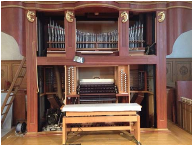
Orgeltisch während der Sanierung
