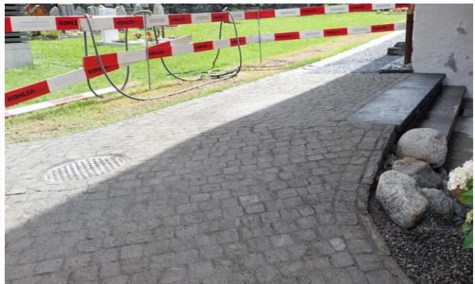
Mit dem neuen Abflusskanal auf der Nordseite der Kirche und einem zusätzlichen Tritt bei der Treppe kann das Wasser nun nicht mehr direkt über die Stufen in die Ausgrabungen gelangen.
